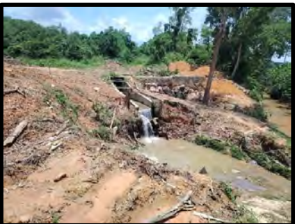
PEMBANGUNAN KESAN TEGUH (KAWALAN SUNGAI SELUAANG)
