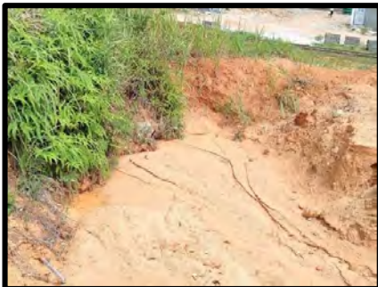
PEMBANGUNAN HADAPAN INDUSTRI WAJA INDAH (LIMPAHAN AIR KE JALAN UTAMA INDUSTRI WAJA)
